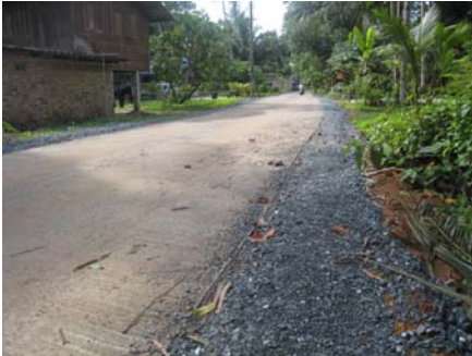
6. ปรับปรุงและซ่อมแซมถนนสายโรงกลึงสมเกียรติ หมู่ที่ 11
