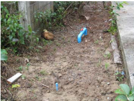
12. ฝังท่อระบายน้ำ คสล.หมู่ที่ 3,9
