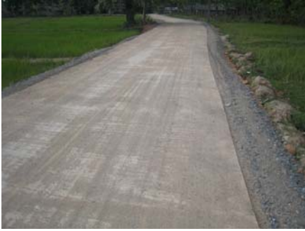
5. ก่อสร้างถนน คสล.สายมัสยิดอุตะภา หมู่ที่ 11
