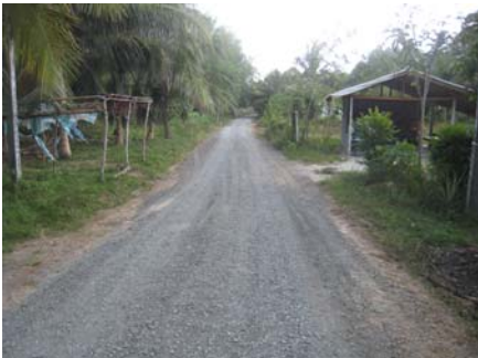
7. ก่อสร้างถนน คสล.จากซอยสุทธิรักษ์-โรงเรียนวัดชัยธารามประดิษฐ์ หมู่ที่ 15
